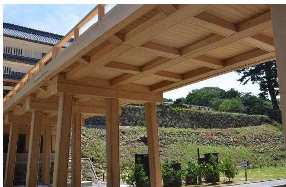
柱脚部及び上げ裏
