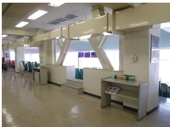
鉄骨ブレースによる補強
