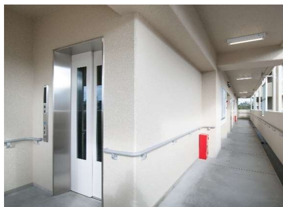
67号棟、68号棟共用エレベーター
