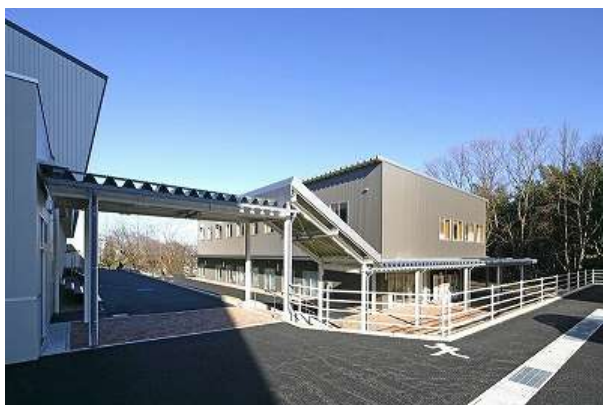
渡り廊下B棟～トレーニング棟 連絡通路
