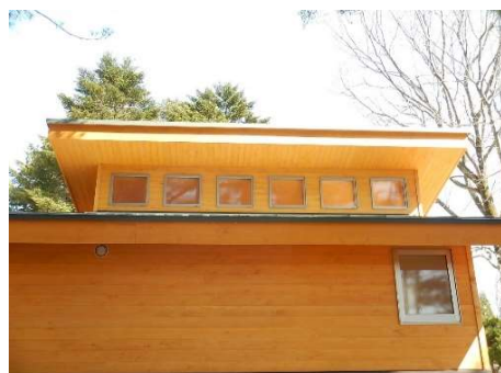
通路上部(採光用の高窓)
