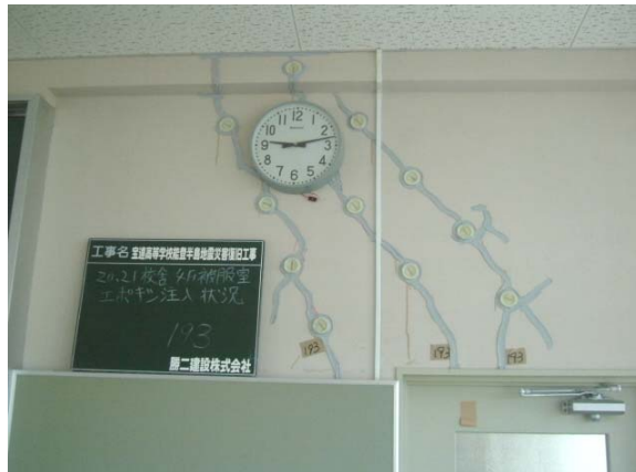
壁クラック補修状況
