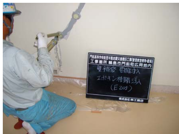
エポキシ樹脂注入状況
