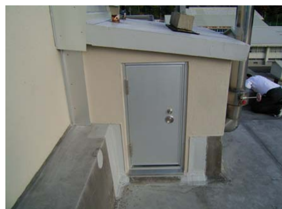
同左の修繕後
