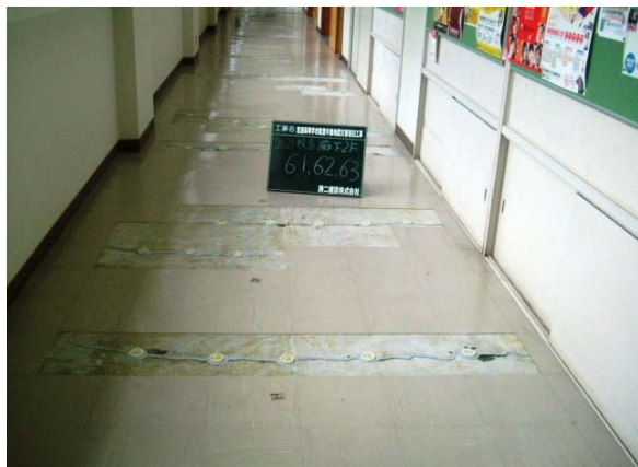
床クラック補修状況
