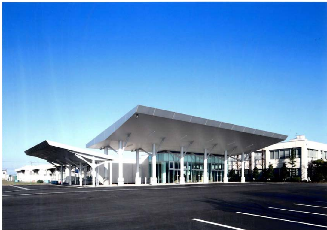
正面入口 外観
