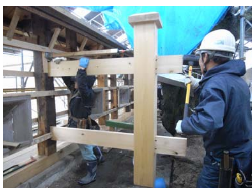
附属左方太鼓塀控柱組立状況
