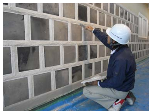
続櫓の海鼠壁目地漆喰塗状況
