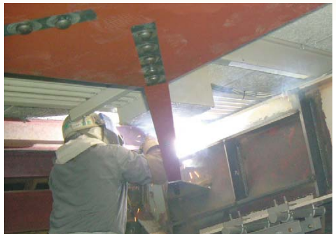
鉄骨溶接状況
