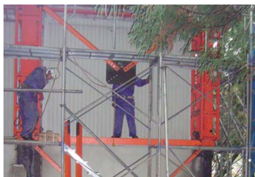
外壁ブレースによる補強
