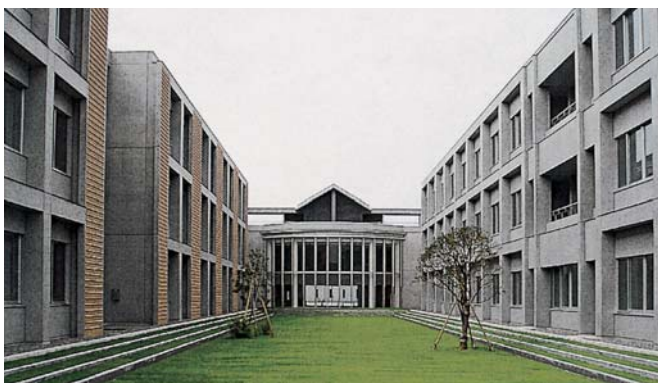
中庭よりエントランスホールを見る
