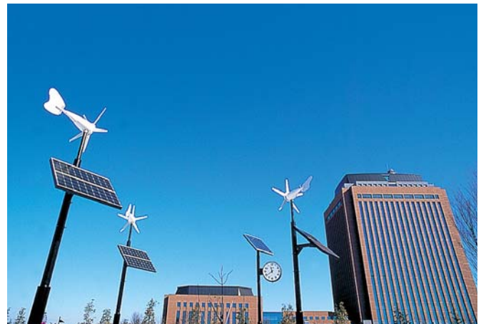
風力・太陽光発電システム
