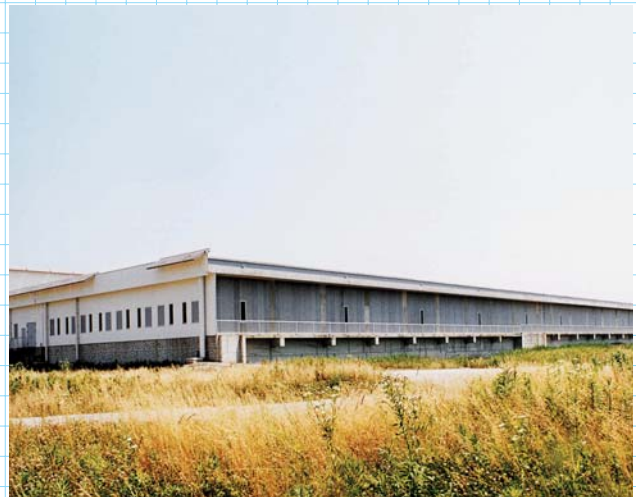
水処理棟二次覆蓋2
