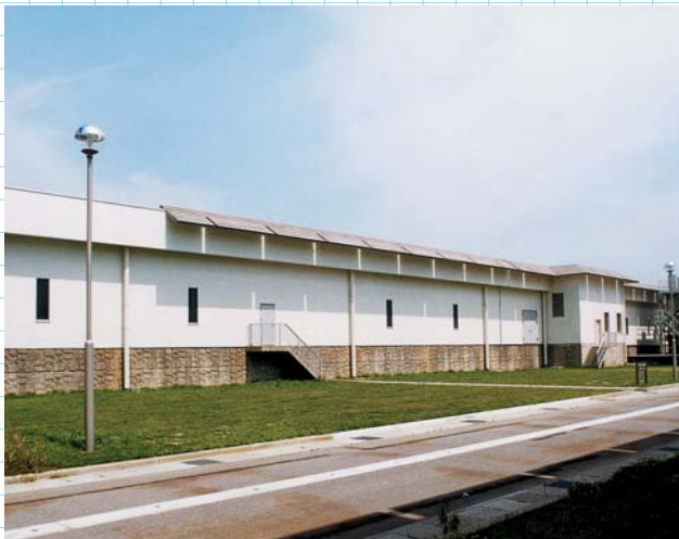
水処理棟二次覆蓋1
