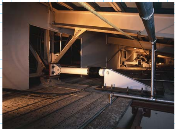
制震ダンパーによる耐震補強工事
