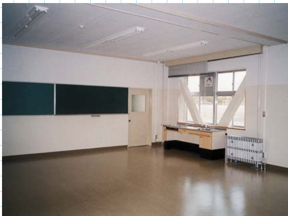
鉄骨による耐震補強工事
