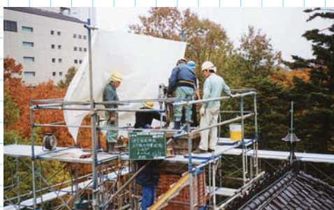
煙突構造補強工事
