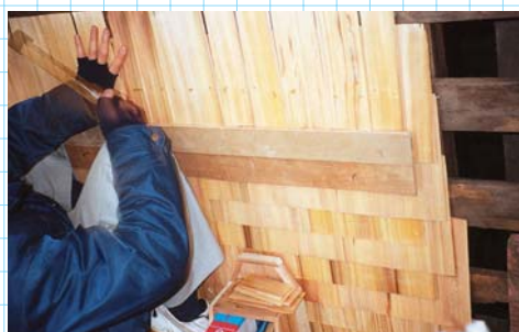
木羽板葺替状況
