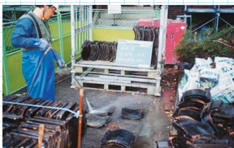
再使用瓦の洗浄状況
