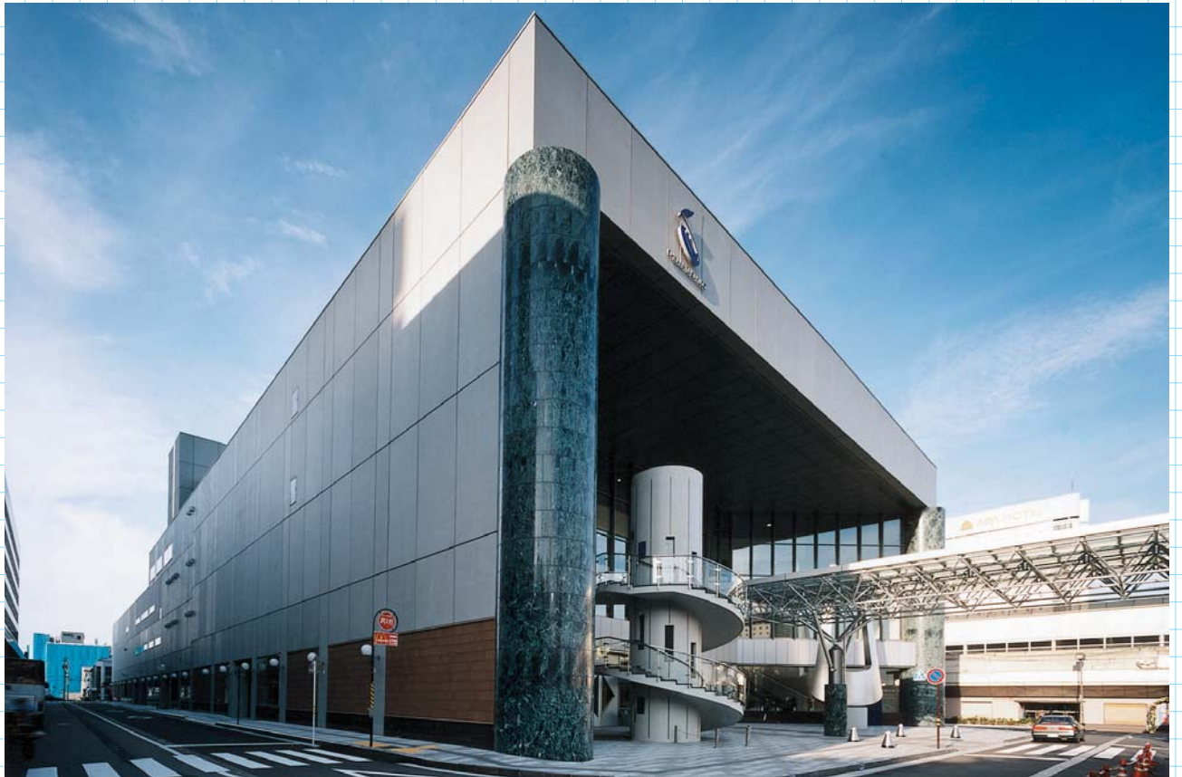
コンサートホール側外観
