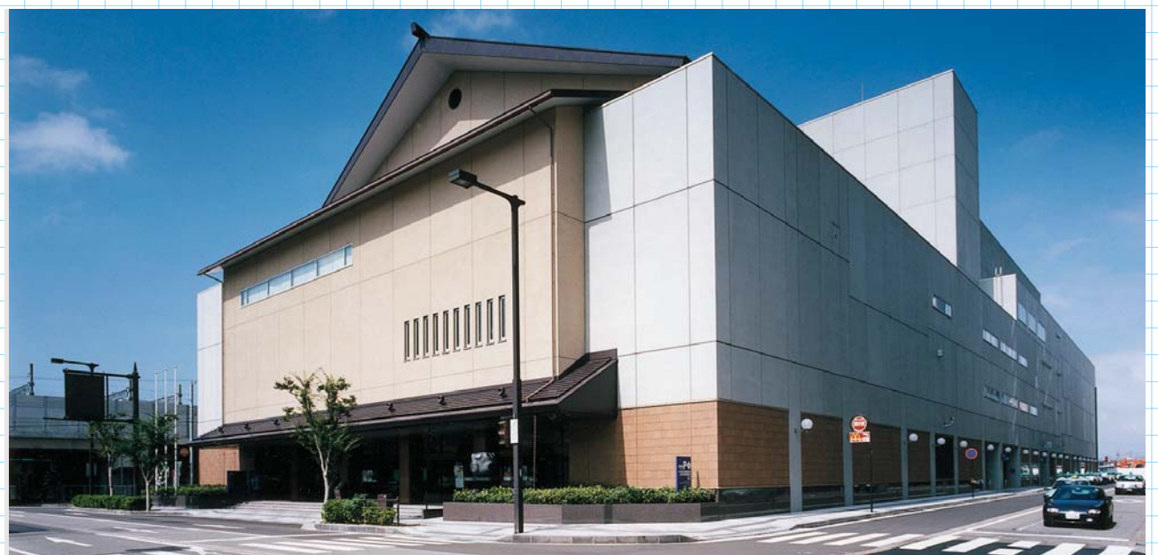
邦楽ホール側外観
