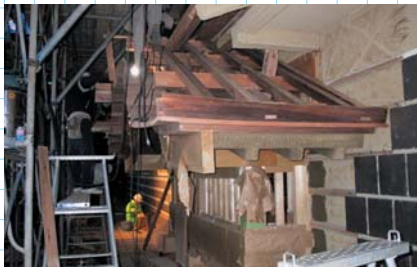
石落し屋根下地
