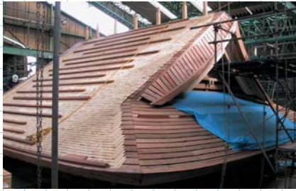
橋爪門続櫓の土居葺と屋根下地
