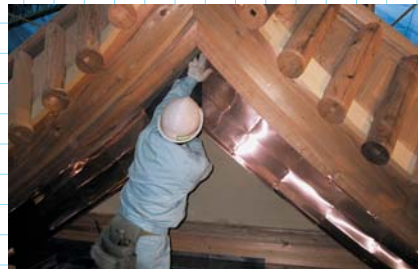
破風の銅板張り
