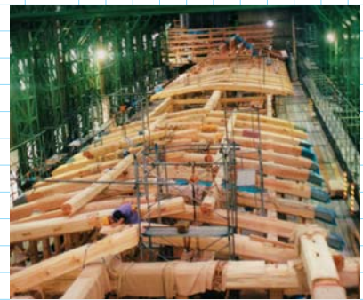
五十間長屋小屋梁
