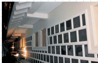
壁白漆喰目地塗
