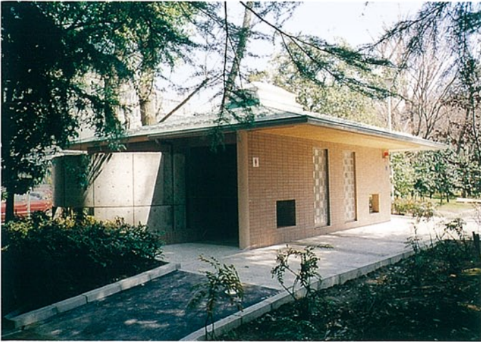
中央公園公衆便所
