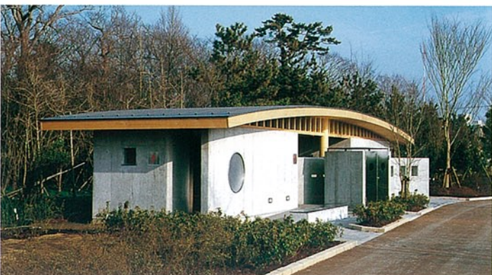
大野湊緑地公園公衆便所
