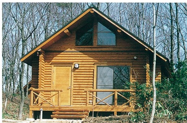
ログハウス ●所在/河北郡津幡町字下河合 ●完成/H.9 ●構造/W造: 2F ●延床/48.60㎡
