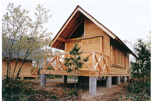
バンガロー ●所在/輪島市三井町 ●完成/H.7 ●構造/W造:1F ●延床/14.33㎡
