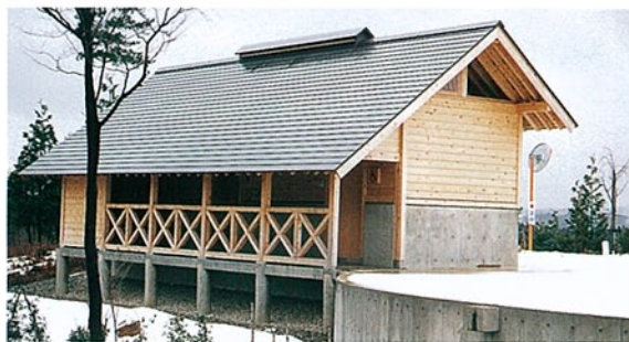
便所 ●所在/輪島市三井町 ●完成/H.8 ●構造/W造:1F ●延床/56.70㎡
