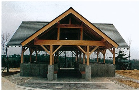
炊事舎 ●所在/輪島市三井町 ●完成/H.8 ●構造/W造:1F ●延床/56.88㎡
