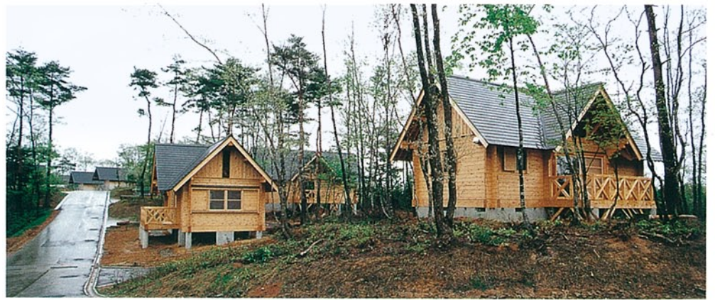
オートキャンプ場施設 ログハウス ●所在/輪島市三井町 ●完成/H.10 ●構造/W造:2F ●延床/49.68㎡
