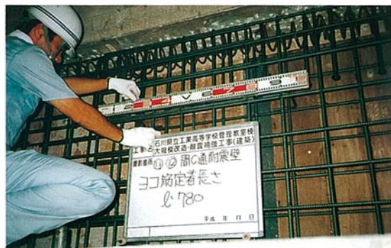
鉄筋コンクリートによる耐震補強工事
