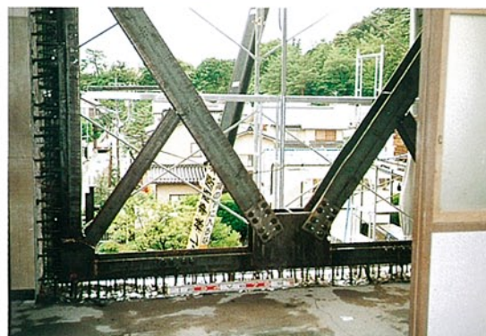
鉄骨による耐震補強工事
