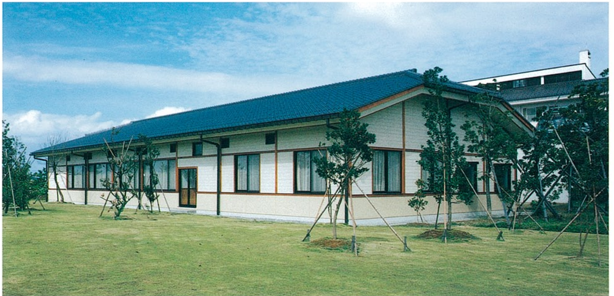
会議棟 ●所在/金沢市才田町 ●完成/H.1.9 ●敷地/59,797㎡ ●構造/S造:1F ●延床/554㎡
