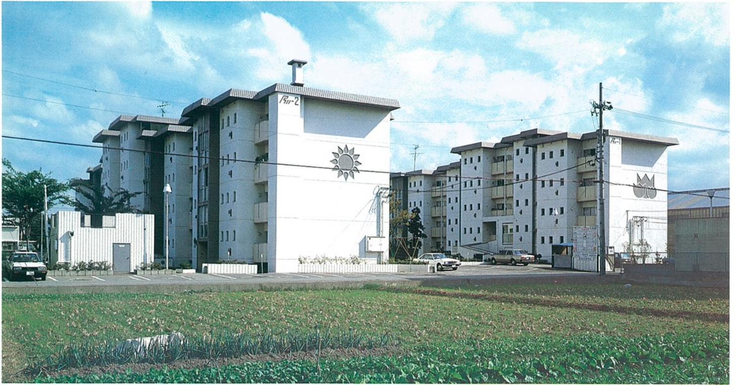
■本町住宅団地 石川郡野々市町本町 ●竣工年度/S.50~53
