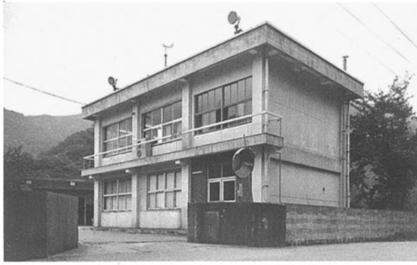
■我谷ダム管理事務所 江沼郡山中町我谷町 ●竣工年度/S.38 ●構造/RC造 2階 ●延床面積/194㎡(281㎡)
