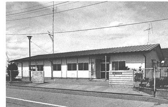
■七尾港湾事務所 七尾市矢田新町 ●竣工年度/S.47●構造/S造 1階 ●延床面積/186㎡(482㎡)
