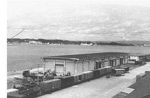
■七尾港上屋 七尾市矢田新町 ●竣工年度/S.42●構造/RC造 1階 ●延床面積/1,968㎡
