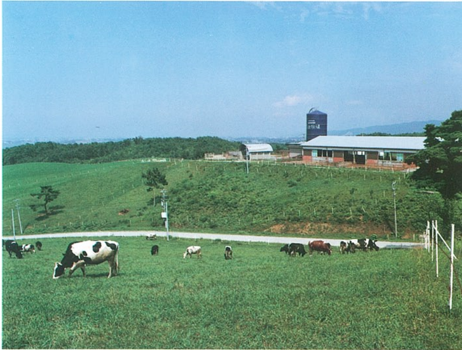
辰の口放牧場 能美郡辰口町岩内 ●竣工年度/S.47 ●構造/RC造 1階 ●延床面積/154㎡(2,667㎡)
