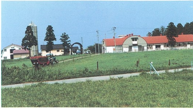
肉牛生産指導所 珠洲郡内浦町松波 ●竣工年度/S.55 ●構造/RC造 1階 ●延床面積/410㎡(4,197㎡)
