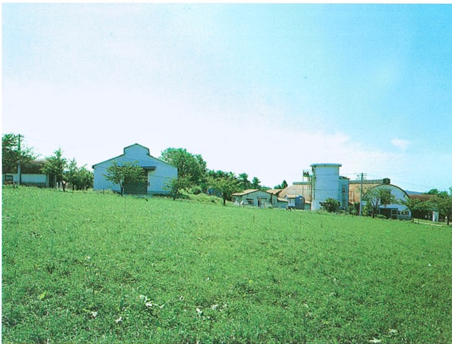
畜産試験場 羽咋郡押水町坪山 ●竣工年度/S.39 ●構造/RC造 2階 ●延床面積/1,131㎡(5,243㎡)
