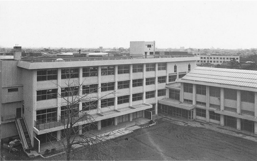
保育専門学園 金沢市泉町 ●竣工年度/S.43●構造/RC造 4階●延床面積/3,669㎡(3,674㎡)
