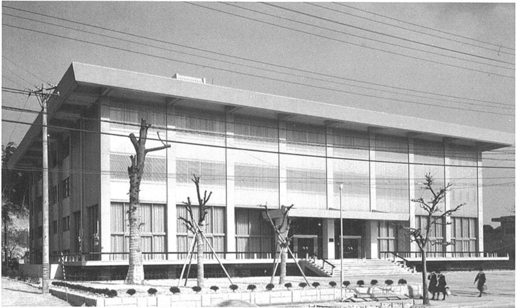
■社会教育会館 金沢市本多町 ●竣工年度/S.40●構造/SRC造 地下2階 地上4階●延床面積/6,394㎡
