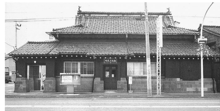
■町民文化館 金沢市尾張町 ●建築M.40 改築S.51 ●構造/W造 1階 ●延床面積/339㎡
