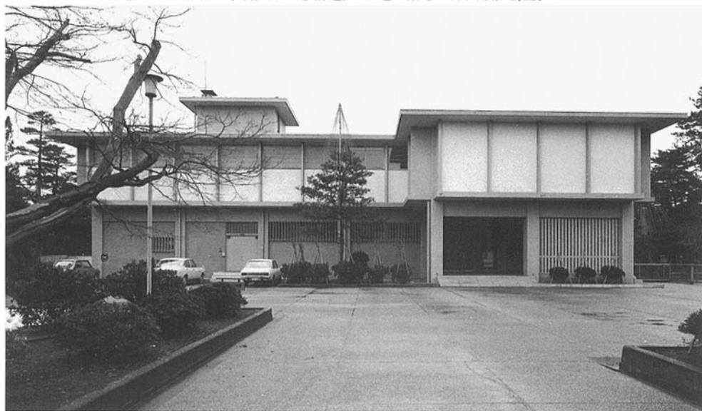
■美術館 金沢市兼六町 ●竣工年度/S.42 ●構造/RC造 2階 ●延床面積/2,225㎡
