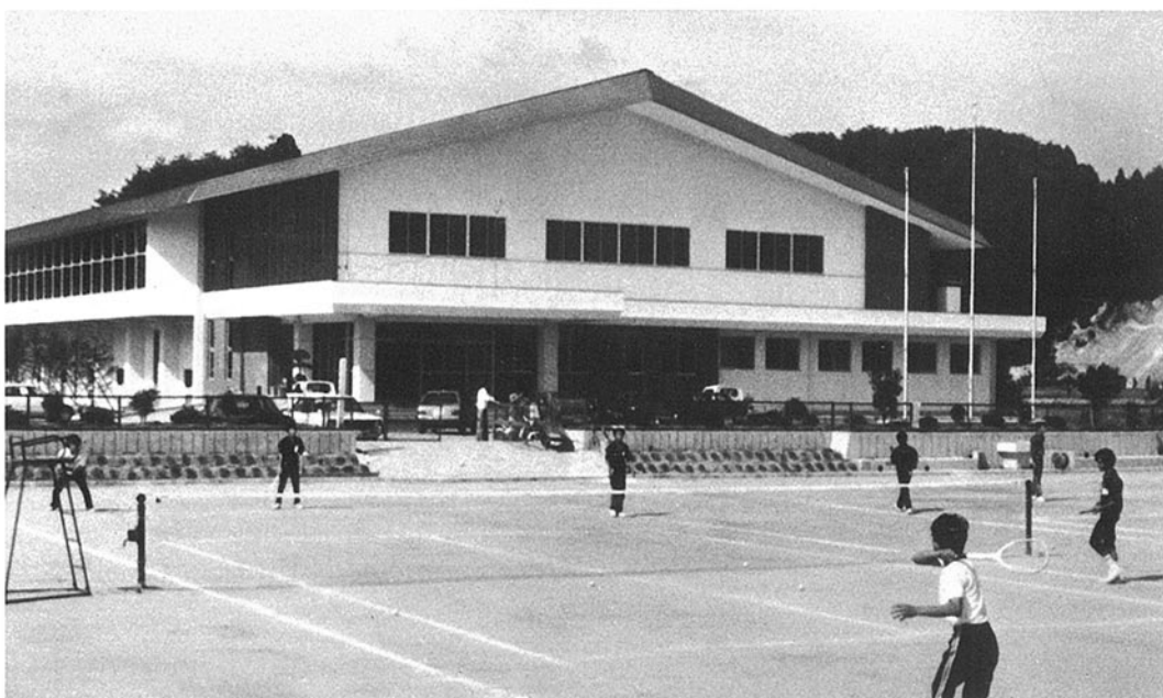
■珠洲健民体育館 珠洲市野々江町 ●竣工年度/S.53●構造/RC造 2階●延床面積/2,396㎡
