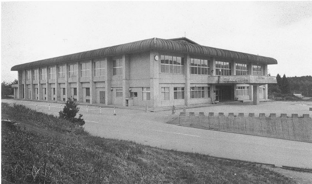
■七尾城山体育館 七尾市後袋町 ●竣工年度/S.45●構造/RC造 2階●延床面積/2,472㎡
