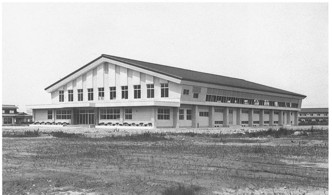
■松任若宮健民体育館 松任市徳丸町 ●竣工年度/S.49●構造/RC造 2階●延床面積/3,048㎡
