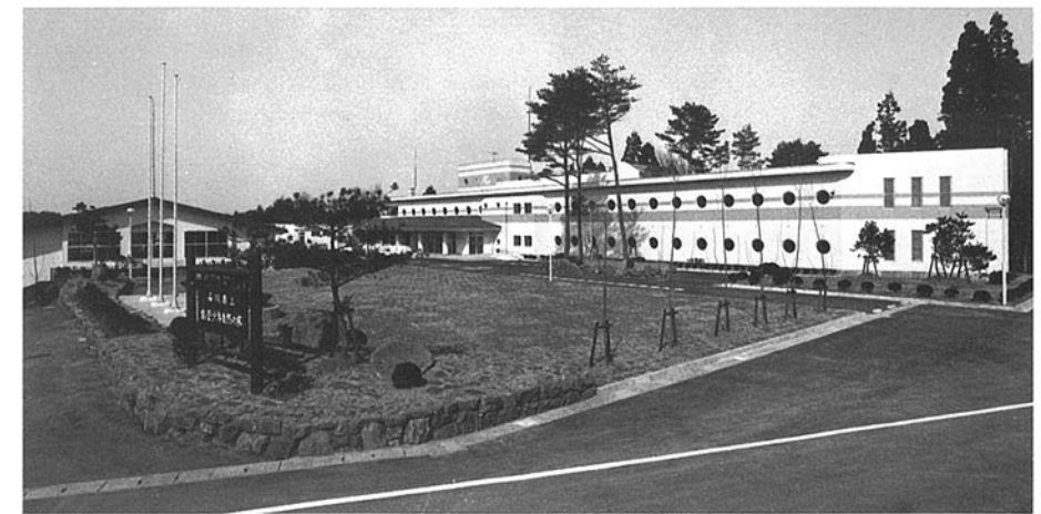
■能登少年自然の家 珠洲郡内浦町九里川尻 ●竣工年度/S.56●構造/RC造 2階●延床面積/2,188㎡(2,409㎡)
