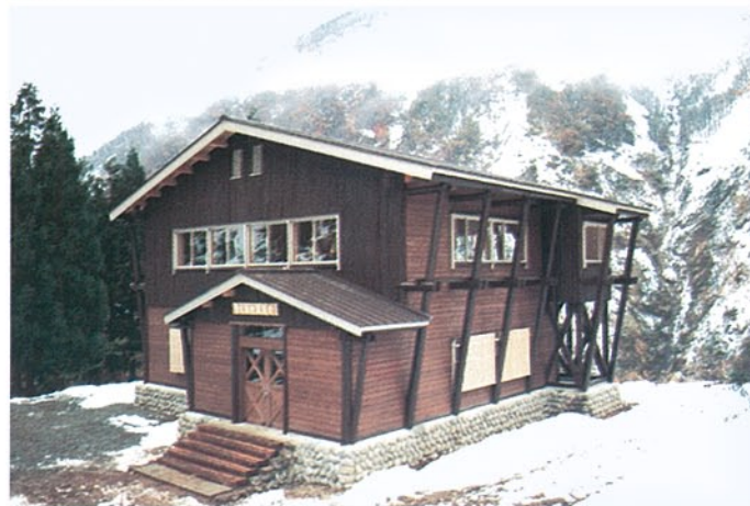
●竣工年度/S.56●構造/W造 2階●延床面積/225㎡(245㎡)
