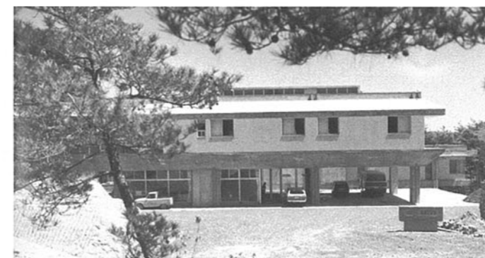
■国民宿舎能登とき荘 羽咋郡富来町酒見 ●竣工年度/S.47●構造/RC造 2階●延床面積/1,591㎡
