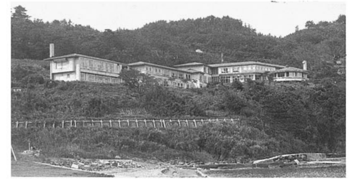
■国民宿舎能登きのうら荘 珠洲市折戸町木ノ浦 ●竣工年度/S.45●構造/RC造 2階●延床面積/2,349㎡
