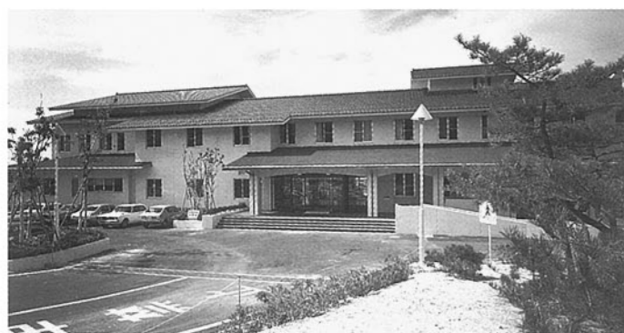
■国民宿舎片野荘 加賀市片野 ●竣工年度/S.53●構造/RC造 2階●延床面積/1,828㎡
