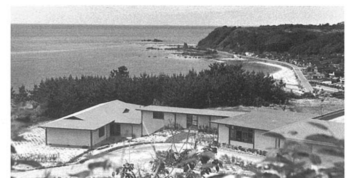
■国民宿舎能登つるぎ荘 鳳至郡門前町剣地 ●竣工年度/S.45●構造/RC造 2階●延床面積/1,160㎡
