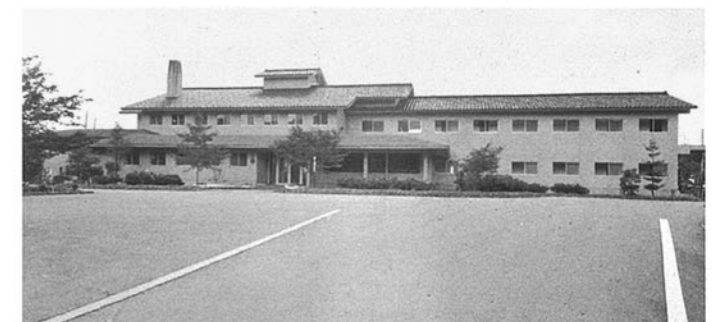
■国民宿舎能登うしつ荘 鳳至郡能都町羽根 ●竣工年度/S.47●構造/RC造 2階●延床面積/1,516㎡
