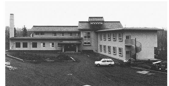
■国民宿舎能登やなぎだ荘 鳳至郡柳田村 ●竣工年度/S.50●構造/RC造 2階●延床面積/1,509㎡
