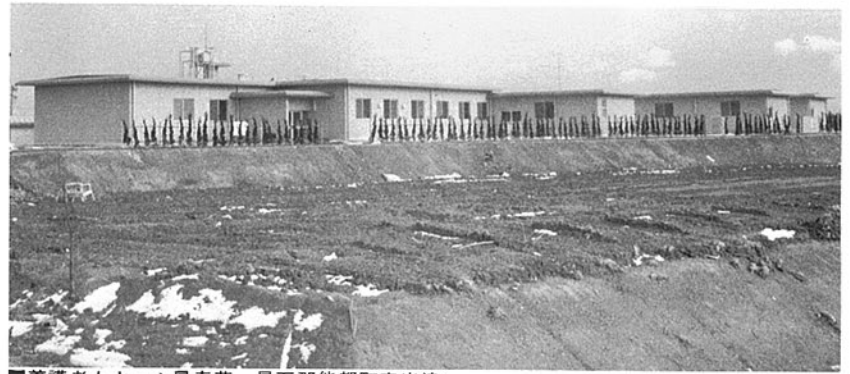
■養護老人ホーム鳳寿荘 鳳至郡能都町宇出津 ●竣工年度/S.44●構造/RC造 1階 ●延床面積/3,206㎡(3,458㎡)
