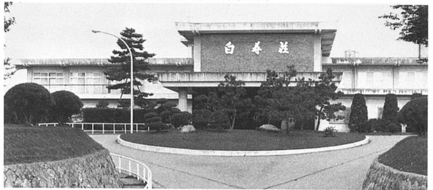
■老人保養ホーム白寿荘 小松市木場町 ●竣工年度/S.44●構造/RC造 2階●延床面積/1,921㎡
