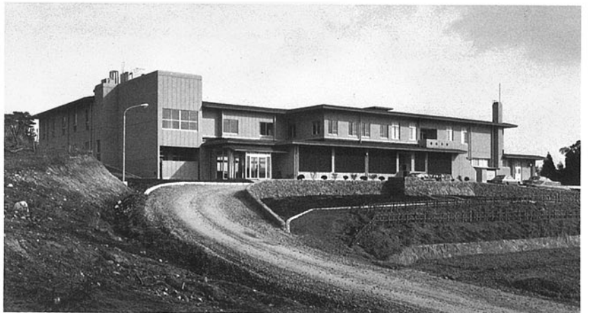
■老人保養ホーム宝立荘 珠洲市宝立町春日野 ●竣工年度/S.48●構造/RC造 2階●延床面積/1,447㎡
