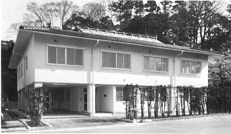
■清心寮・白百合寮 金沢市石引町 ●竣工年度/S.56●構造/RC造 2階●延床面積/1,859㎡
