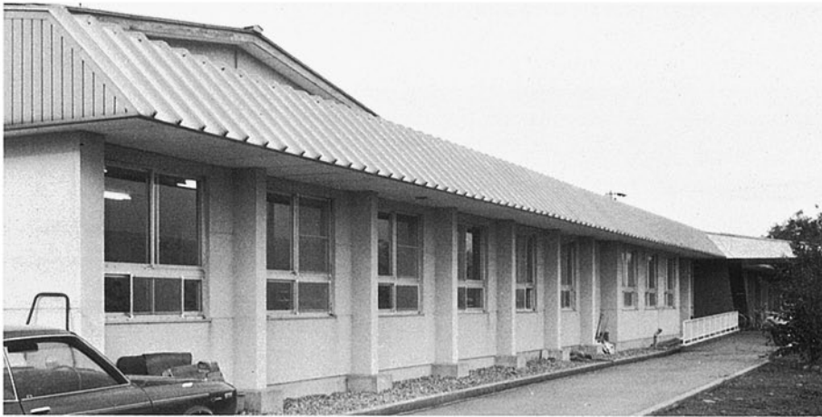
■石川サニーメイト 石川郡野々市町末松 ●竣工年度/S.50●構造/S造 2階●延床面積/461㎡(1,141㎡)
