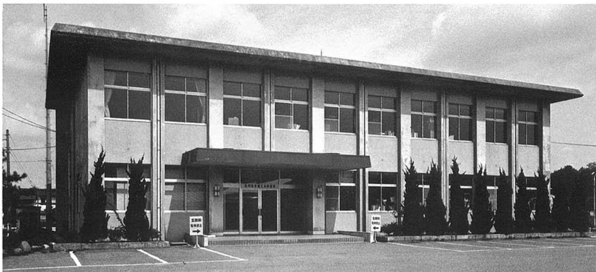
■津幡土木事務所 河北郡津幡町加賀爪 ●竣工年度/S.46●構造/RC造 2階●延床面積/637㎡(986㎡)
