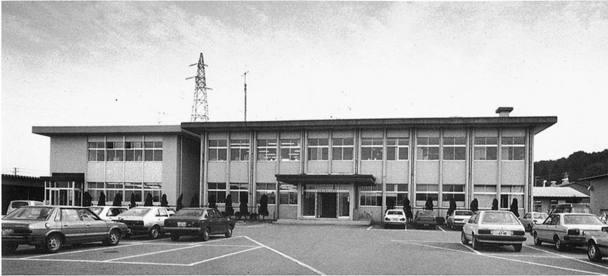
■大聖寺土木事務所 加賀市曾宇町 ●竣工年度/S.48●構造/RC造 2階●延床面積/704㎡(1,048㎡)
