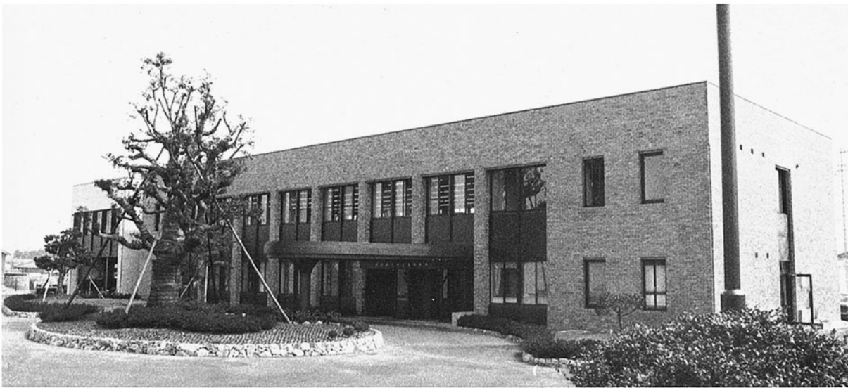
■小松土木事務所 小松市白江町 ●竣工年度/S.56●構造/RC造 2階●延床面積/1,109㎡(2,209㎡)
