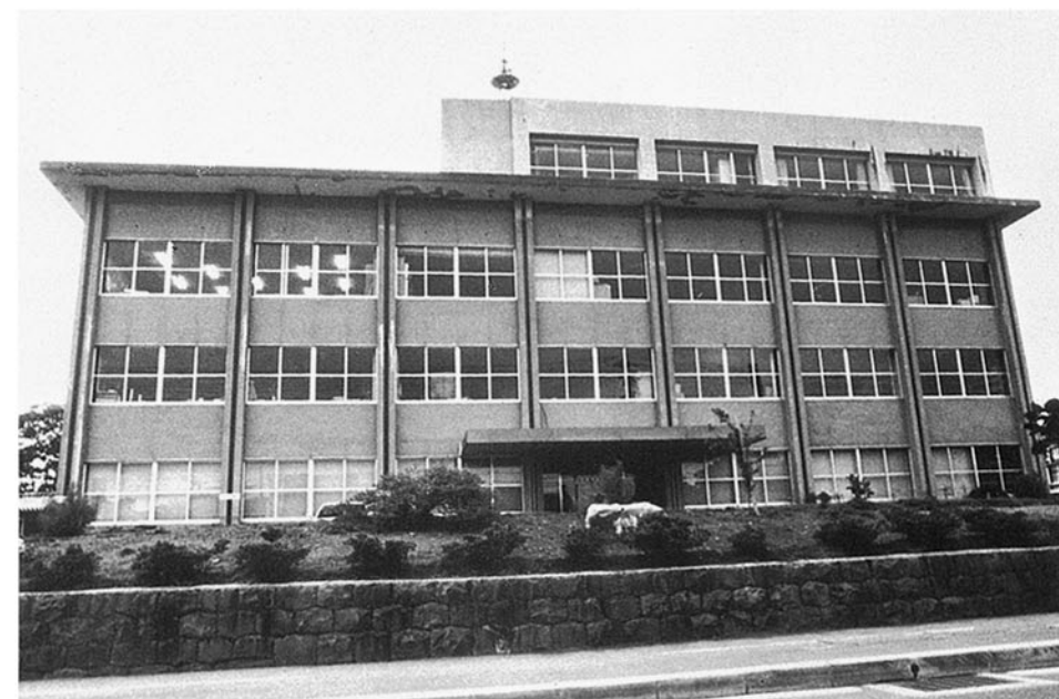
■輪島事務所 輪島市河井町 ●竣工年度/S.44●構造/RC造 4階●延床面積/1,491㎡(2,016㎡)
