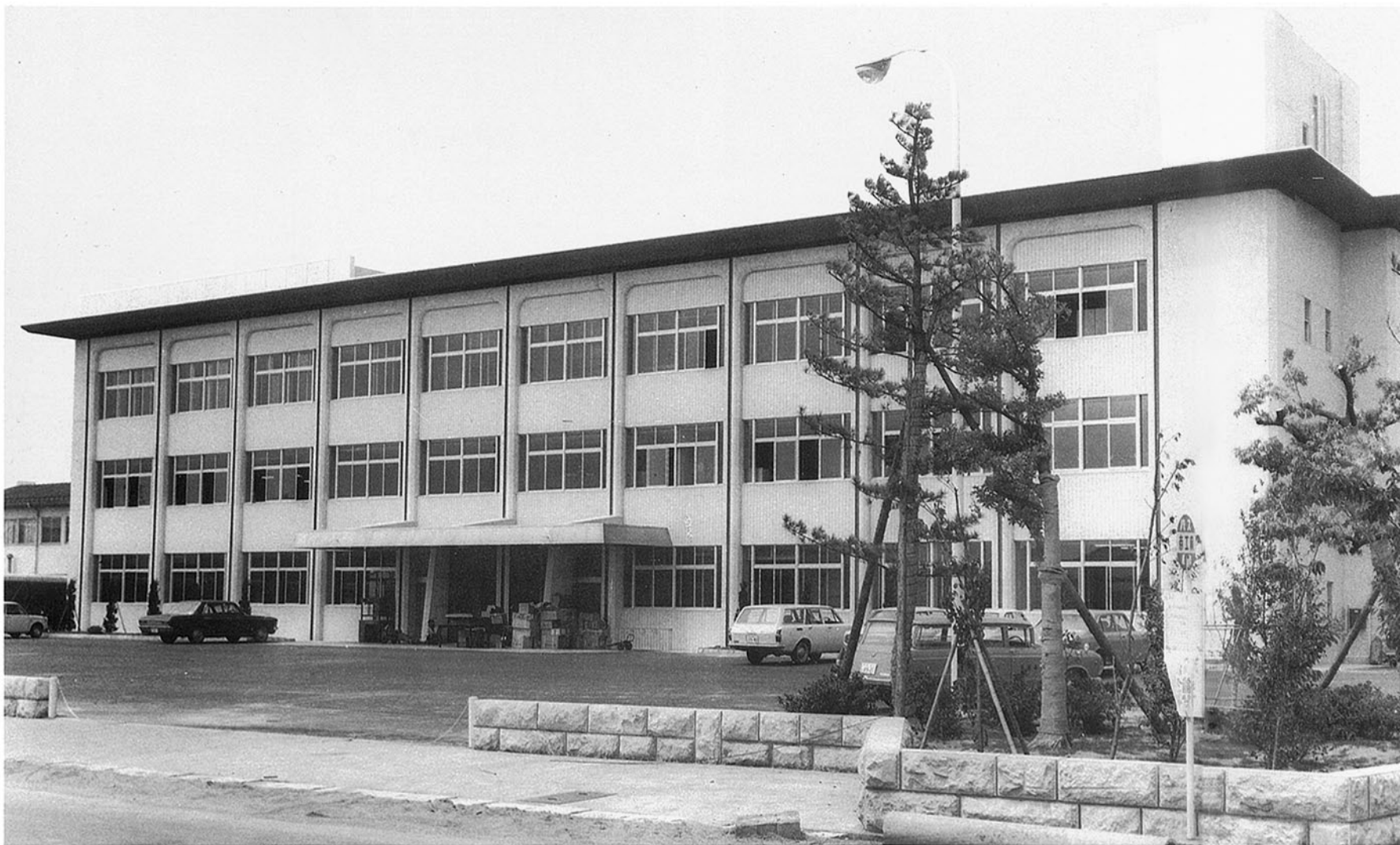
■小松県税事務所 小松市園町 ●竣工年度/S.46●構造/RC造 3階●延床面積/2,264㎡(2,701㎡)
