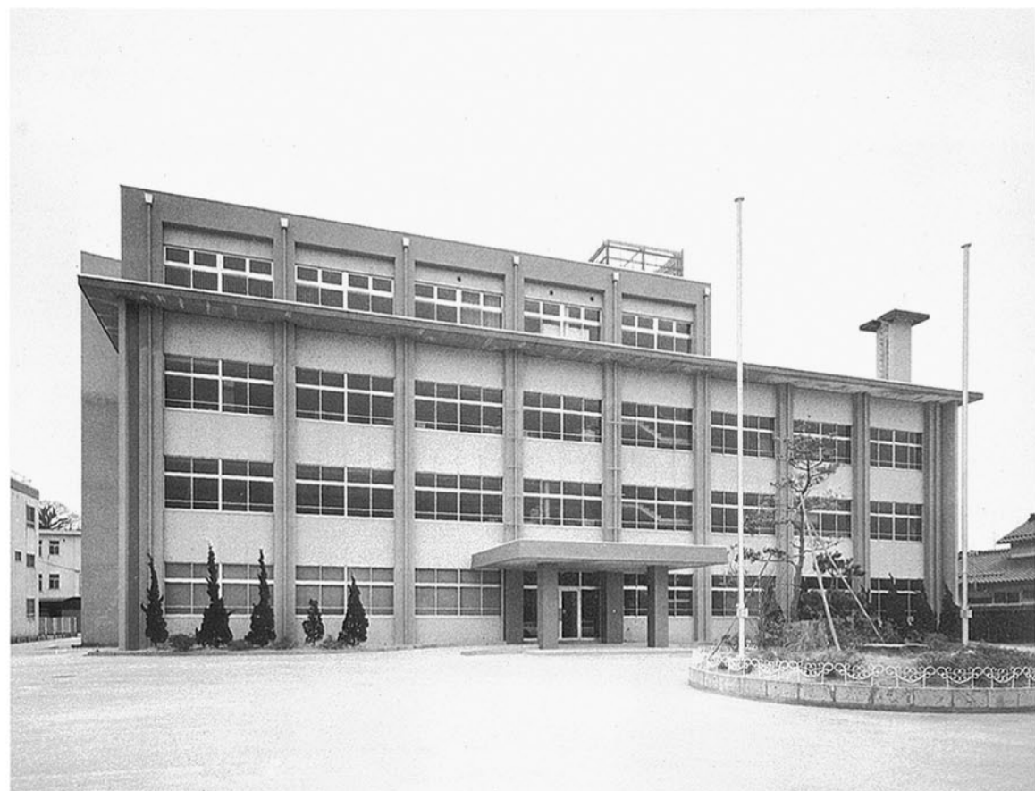
■七尾事務所 七尾市小島町 ●竣工年度/S.45●構造/RC造 4階●延床面積/2,031㎡(2,364㎡)
