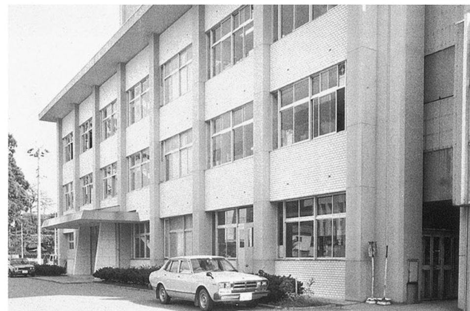
■珠洲合同庁舎 珠洲市上戸町北方 ●竣工年度/S.47●構造/RC造 3階●延床面積/1,246㎡(1,610㎡)
