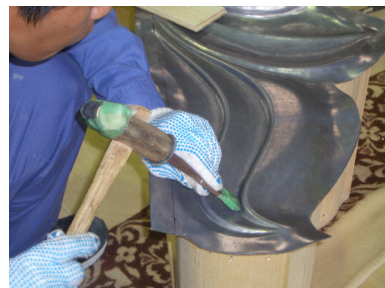
③鰭打出し 鰭の凹凸を養生された木製鑿 たがね にて打出す。
