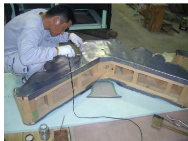
⑤背面鉛巻き 背面は3枚の鉛板を巻く。継ぎ目は半田付を行う。
