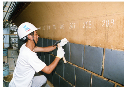
②平瓦取付 荒壁に墨打ちを行い、壁の後ろにある 間渡しに対して平瓦を貝折釘で止める。
