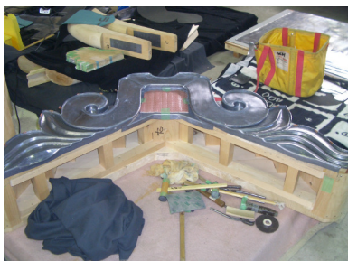
④正面の鉛巻き完了 ハゼ部分に銅板を掛けて木材に釘止めとし、表面に釘が表れないように工夫してある。
