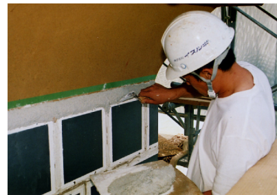
③目地砂漆喰塗り 海鼠壁の目地は砂漆喰を3回に分けて 塗り、2層目に麻縄を仕込む。
