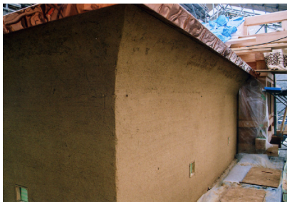
①荒壁 (斑直し) 完了 むらなお 荒土を塗り終えた状況。
