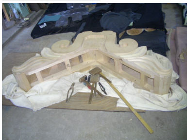
①鉛巻き着手前 木工事としての鬼の製作が完了。能登ヒバを使用、中は空洞である。
