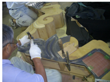
②鏡・鰭の加工取付 梅鉢文様を打出した鏡を取付け、鰭部分を加工する。
