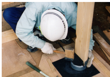
④軒丸瓦加工状況 鉛軒丸瓦を木下地に被せ、 背面を曲げ込む。
