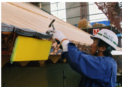
⑦軒平瓦取付け状況 鉛軒平瓦を被せ、上端と側面に銅釘止め。
