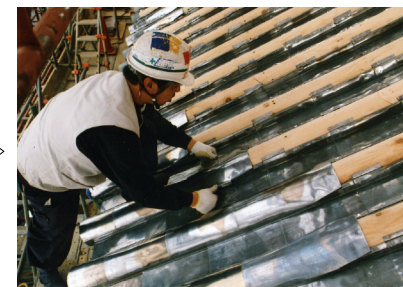
⑩鉛丸葺き状況 平葺きと目を半分ずらして葺く。
