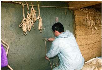
④ 大直し（下縄伏せ込み）
