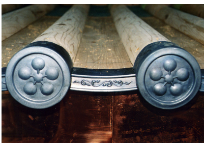
⑧軒丸瓦取付け状況
