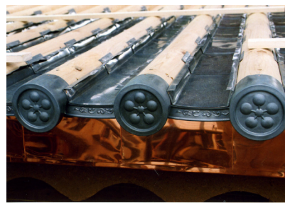
⑨鉛平葺き状況 長さ1尺5寸、葺足1尺1寸。
