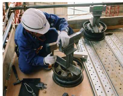
⑤軒平瓦加工状況 木下地の軒平瓦幅に合わせて、鉛軒平瓦側面を加工。
