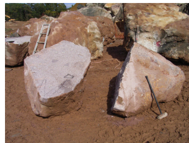
②石割状況 鉄矢を入れてハンマーで叩いて割る
