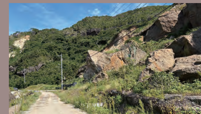
崩落した巨大な岩が道路脇に多数見られる
