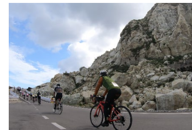
隆起海岸道路（逢坂トンネル工区）
