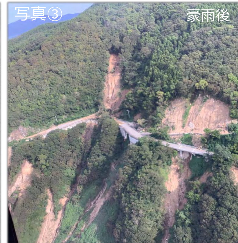
斜面崩壊の拡大
