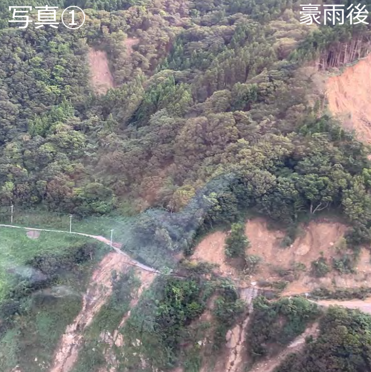
地山の押し出し・斜面崩壊
