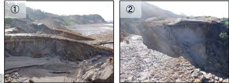
工事用道路豪雨災害後状況写真
