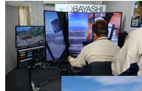
無人化施工実施状況
