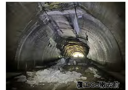
覆工Co、支保工の被災調査状況
