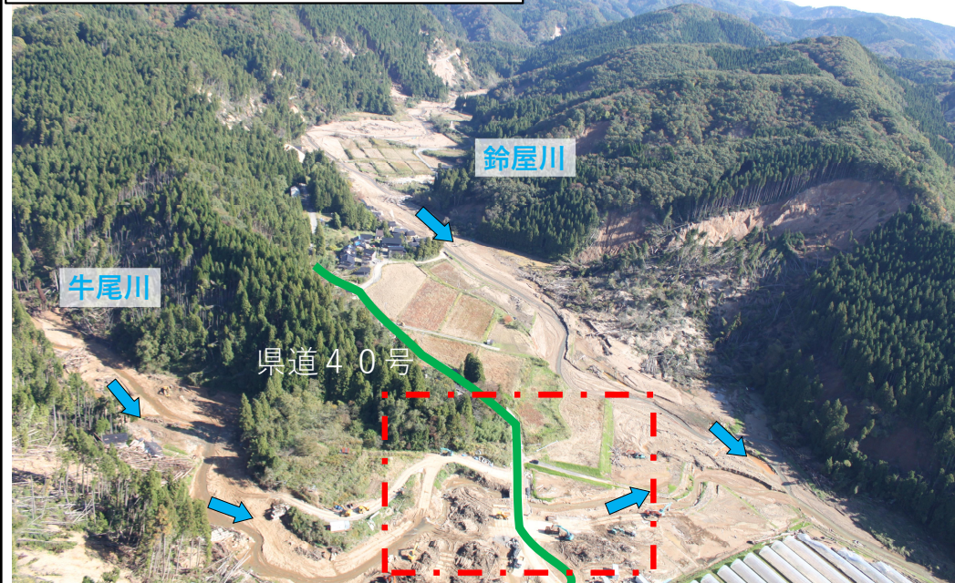
応急復旧工事 (現場状況_11/11撮影)
