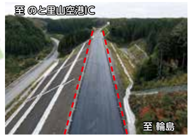
能越自動車道 輪島道路 (令和5年内 供用予定)
