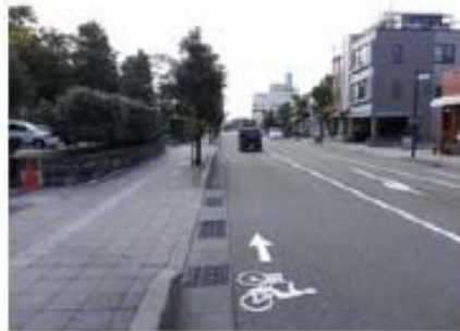
「路面標示の例」
