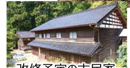
改修予定の古民家
