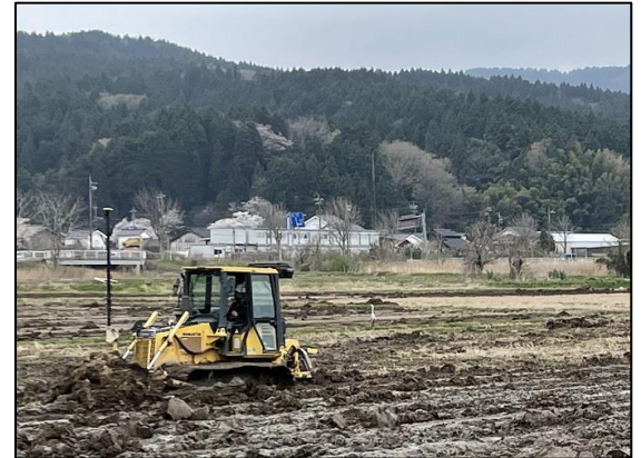
農家による 直営施工
