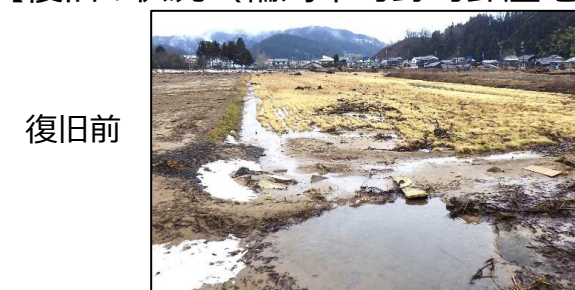
【復旧の状況（輪島市町野町鈴屋地内）】
